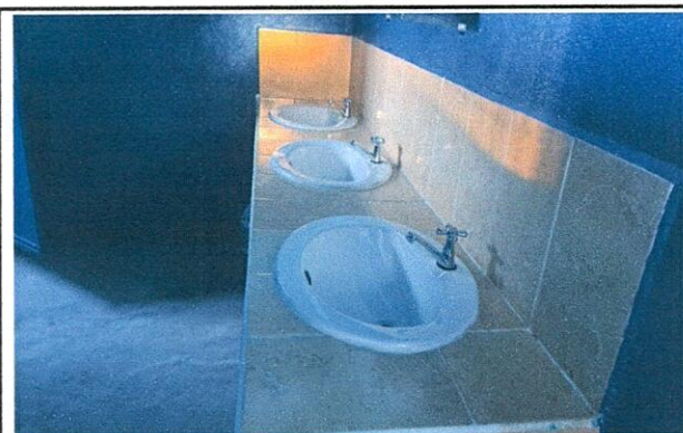
Foto 3: Reparación y sustitución de azulejos en áreas de servicios sanitarios.
