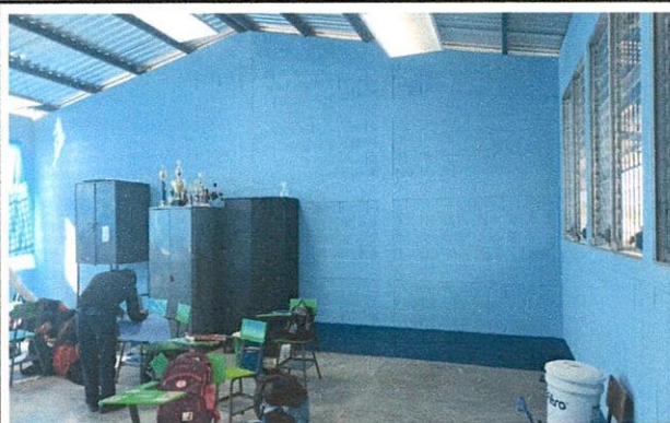
Foto1: Mejoramiento de pintura a base de agua en módulos de aulas incluyendo aplicación en superficies interiores y exteriores.
