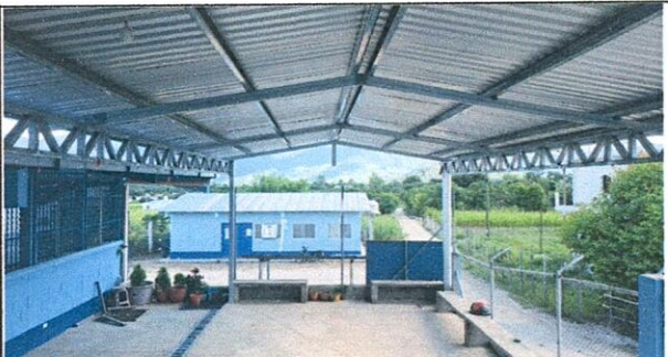
Foto 6: Suministro e instalación de cubierta metálica sobre estructura metálica nueva, lámina galvanizada calibre 26, fijada con tornillos broca de 2, incluyendo capote liso, remates y bajadas metálicas para evacuación de agua pluvial.
